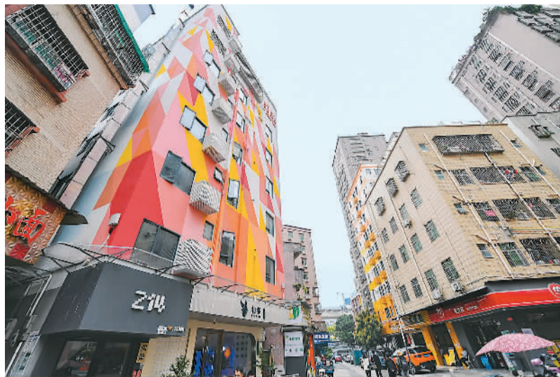
广东省深圳市持续推进城中村住房规模化品质化改造提升，打造了元芬村等新型宜居人文社区。图为深圳市龙华区元芬村，改造后的青年公寓外立面。新华社记者 毛思倩摄
