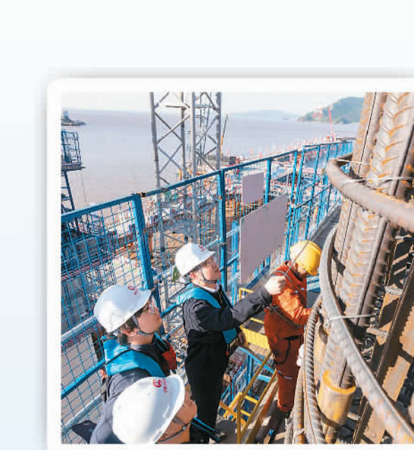
▲世界最宽跨海大桥西堠门公铁两用大桥施工现场，中铁四局项目技术人员在检查墩身钢筋安装间距。
