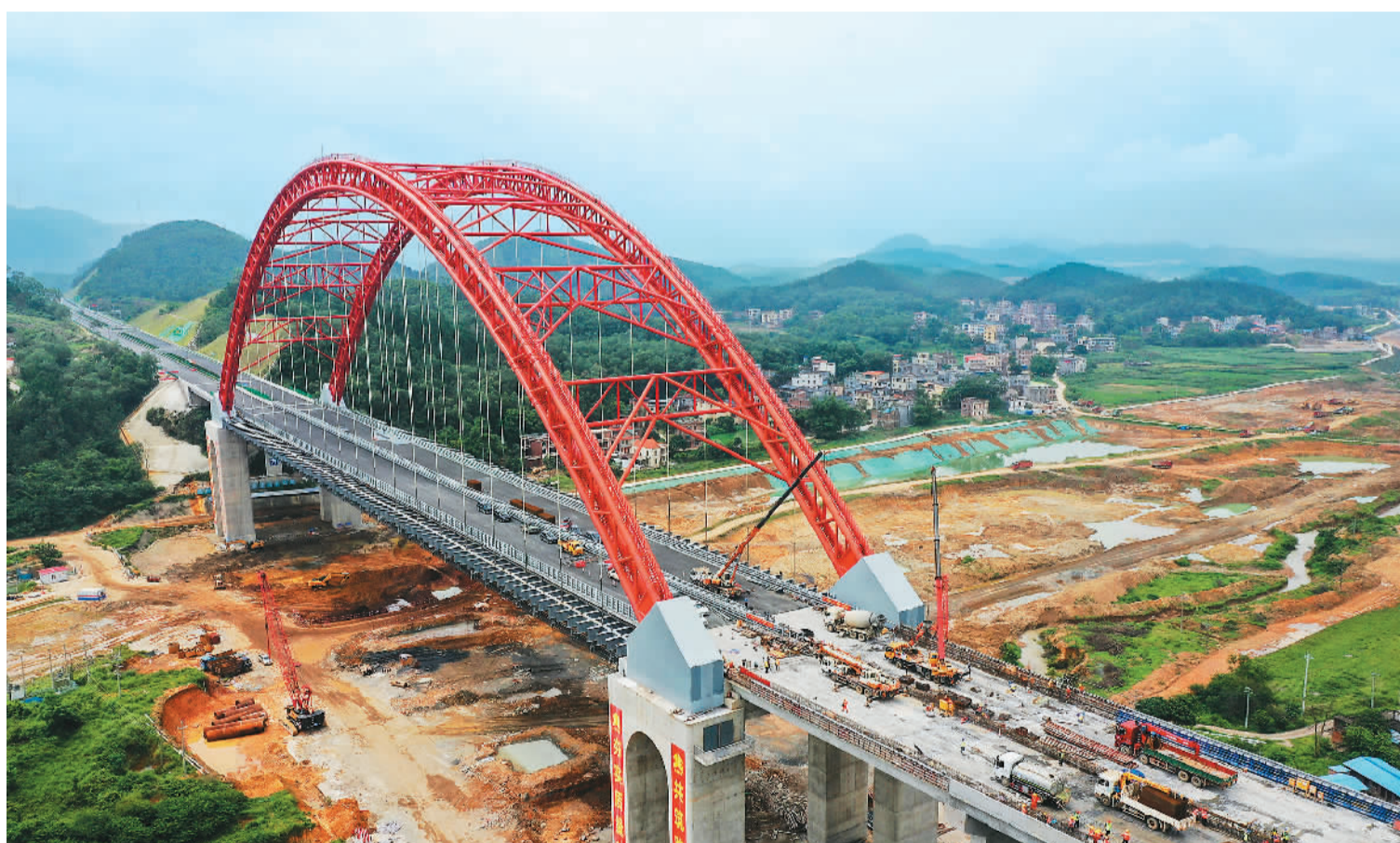
连日来，在跨越广西平陆运河的南港（广西南宁至广东湛江）高速公路旧州特大桥上，工人正紧张施工，力争早日竣工实现通车。南港高速公路西部陆海新通道的重要组成项目，也是广西加快构建对接粤港澳大湾区交通大通道的重要项目。新华社记者 陆波摄
