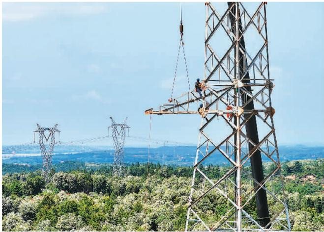
江西500千伏吉安南输变电工程是江西省重点工程,投运后可加强该省吉安市南部电网与吉安主网联络,提升新能源电力消纳能力。图为日前在该项目施工现场,电力工人正在高空进行输电铁塔架设安装作业。
