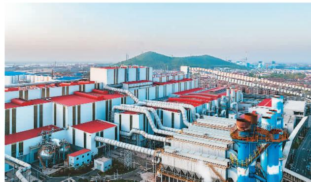
中国宝武马钢集团持续推进钢铁业全流程、系统化减污降碳工作,已成为安徽省第一家环保绩效A级钢铁企业。图为位于安徽省马鞍山市的中国宝武马钢特钢生产线转炉除尘系统。
