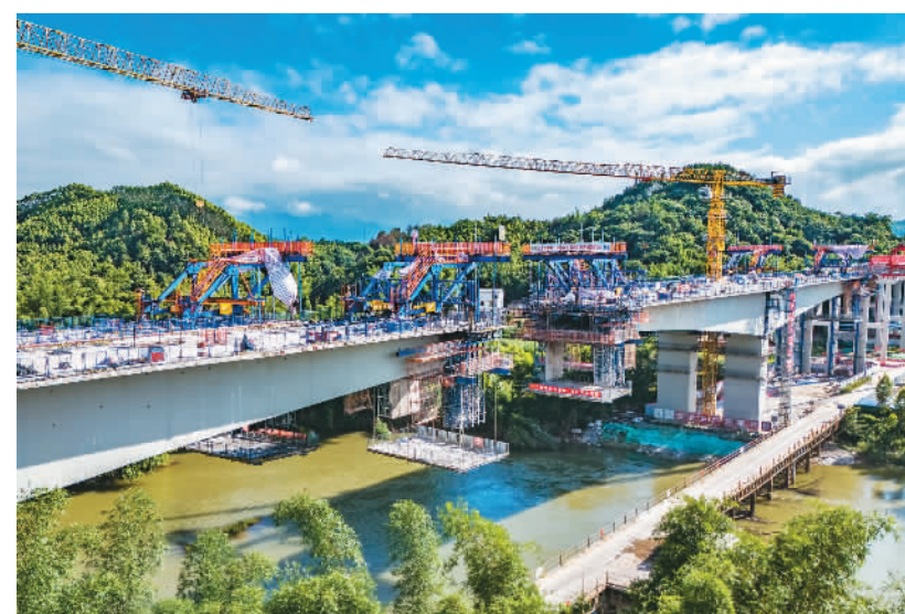
在广东连山至广西贺州高速公路贺江特大桥项目建设现场，工人抢抓晴好天气加紧施工作业，全力冲刺合龙。贺江特大桥是该高速公路项目控制性工程，该高速公路建成后将对区域经济社会高质量发展发挥重要作用。 黎豪图摄（人民视觉）
