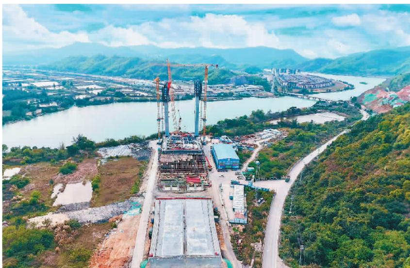
近日，位于广东省深圳市深汕合作区的赤石河特大桥工程段浇筑梁板、腹板浇筑完成。赤石河特大桥是深汕特别合作区小漠国际物流港(一期)陆域形成及配套路网建设项目的核心控制
