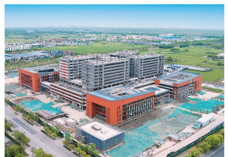
日前，江苏苏州太仓瑞金医院项目进入精装修阶段。该项目由中建八局三公司承建，项目建成后将形成长三角核心区内的“一小时瑞金医疗服务圈”，为当地居民提供超1000张病床床位，切实推动优质医疗资源下沉乡镇，有效解决居民看病难的问题。图为项目建设现场。 王雪摄（人民视觉）
