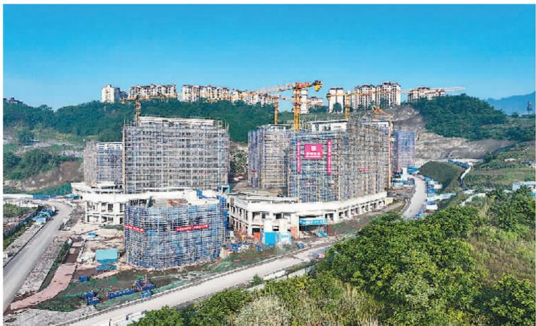
日前，重庆市北碚区首个保障性租赁住房项目全面封顶，进入室内砖墙砌筑阶段。该项目位于北碚区龙凤溪轻轨站旁，总建筑面积约9.14万平方米，住宅共计1067户，预计2025年建成投用，将有效解决北碚区广大企业职工住房问题，助力北碚区加快集聚产业人才。
