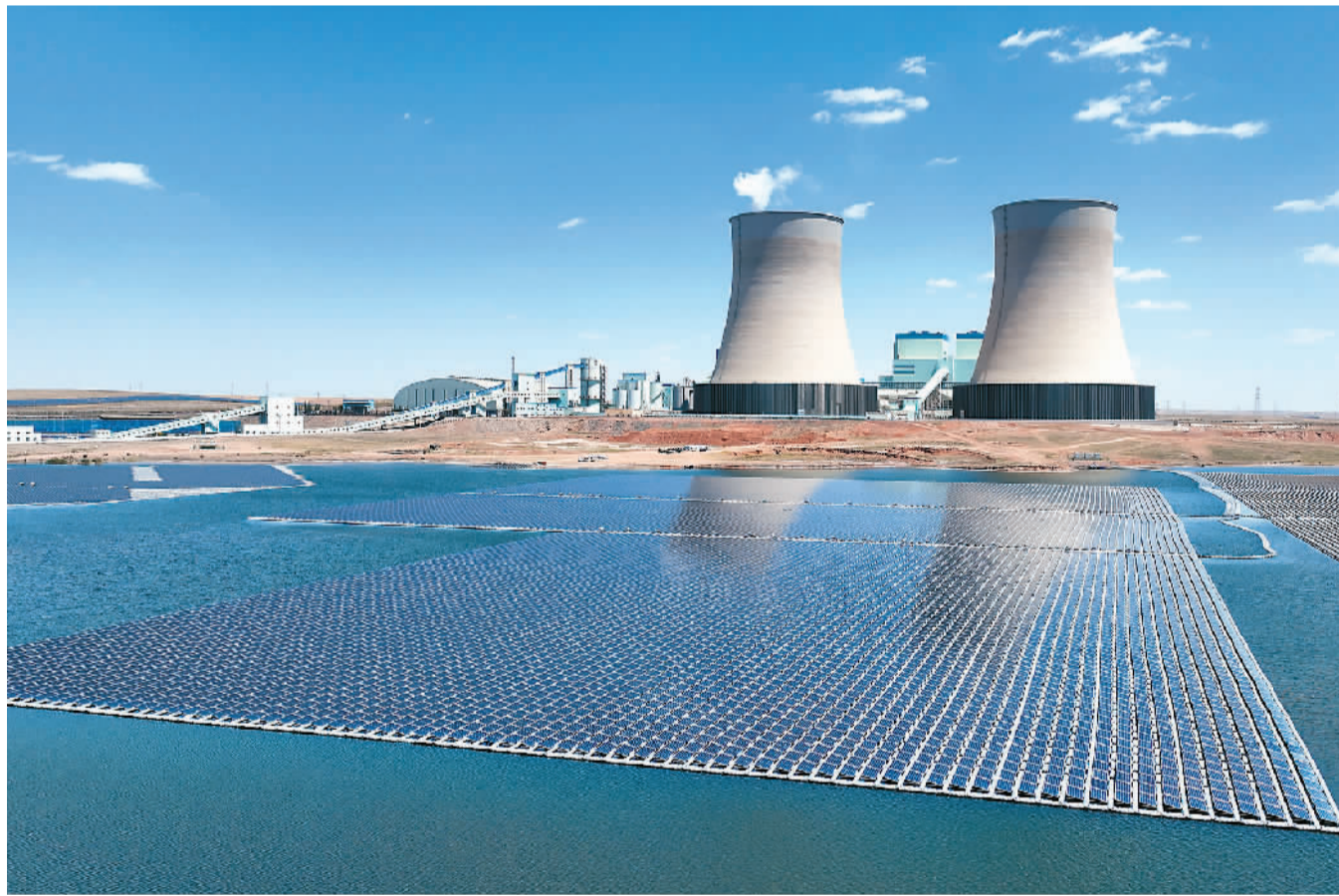
位于宁夏回族自治区灵武市马家滩镇的矿井水水域漂浮分布式光伏发电项目是国内首个高盐、高矿化度矿井水水域漂浮电站。该项目把闲置矿井水水域与新能源发展有机结合，利用矿井疏干水聚集湖的湖域建设光伏电站，实现土地的空间集约利用。图为5月6日拍摄的灵武市马家滩镇矿井水水域漂浮分布式光伏发电项目。 袁宏彦摄（人民视觉）
