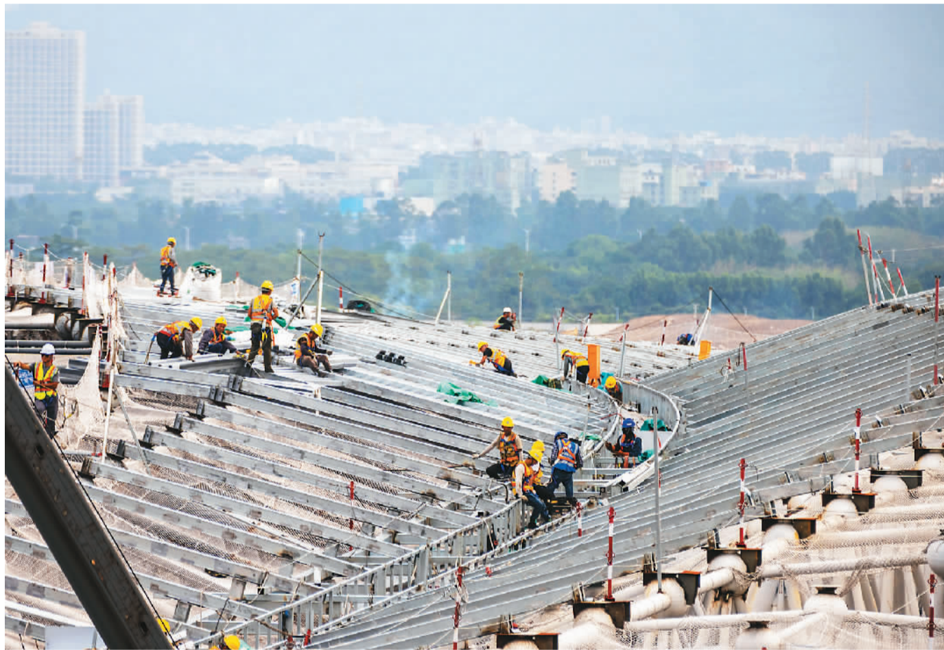
5月4日，广东广州白云国际机场三期扩建工程日前完成钢结构全面封顶的T3航站楼项目，已经进入幕墙、机电、行李系统、民航弱电等专业施工阶段。
