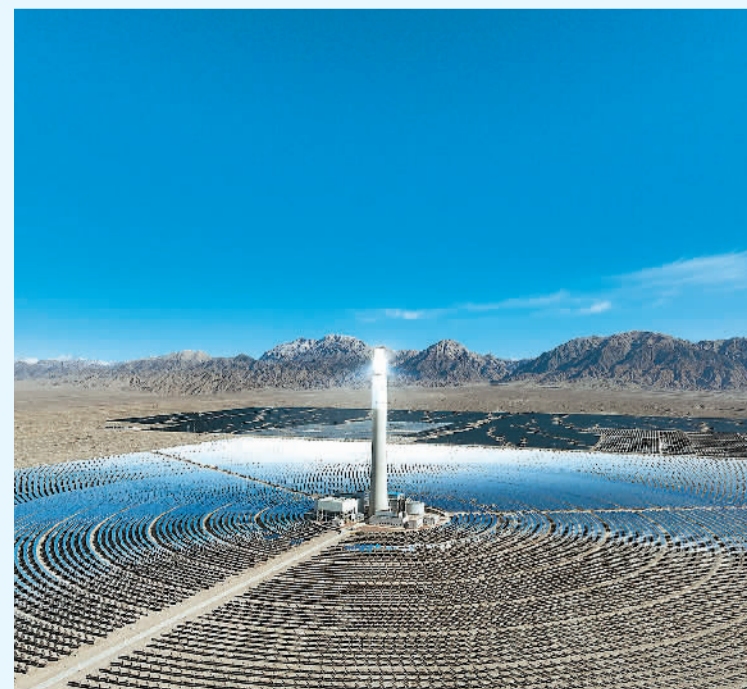
地处柴达木盆地的青海省海西蒙古族藏族自治州德令哈市依托丰富的光照资源、广阔的土地资源，制定新能源产业布局，加速推进大型光伏、光热基地建设，清洁能源产业集群不断壮大，进一步推动柴达木盆地经济发展绿色转型。图为近日在德令哈市光伏(光热)产业园拍摄的光热电站。 新华社记者 张 龙摄
