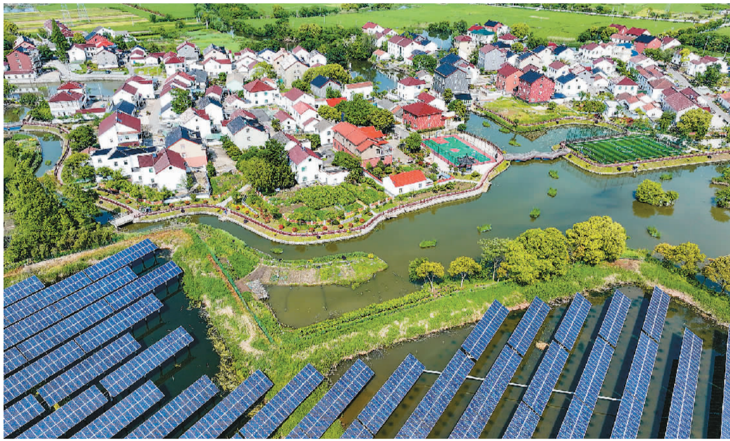
浙江省湖州市长兴县积极盘活闲置土地资源，大力发展新能源产业，多个风力发电和光伏发电项目相继投入运行，有力促进当地经济发展、群众增收。图为位于长兴县吕山乡雁陶村的光伏发电项目。 陈海伟摄（人民视觉）
