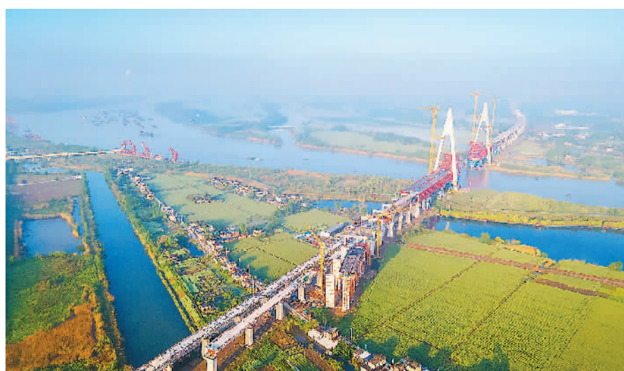
巢马城际铁路是安徽通往上海等长三角城市的高铁新通道,建成后将成为合肥“一小时通勤圈”的重要组成部分,对于进一步完善区域高速铁路网布局、推动皖江城市带发展具有重要意义。图为4月18日,巢马城际铁路马鞍山公铁两用长江大桥副汉航道桥主塔建设现场。
