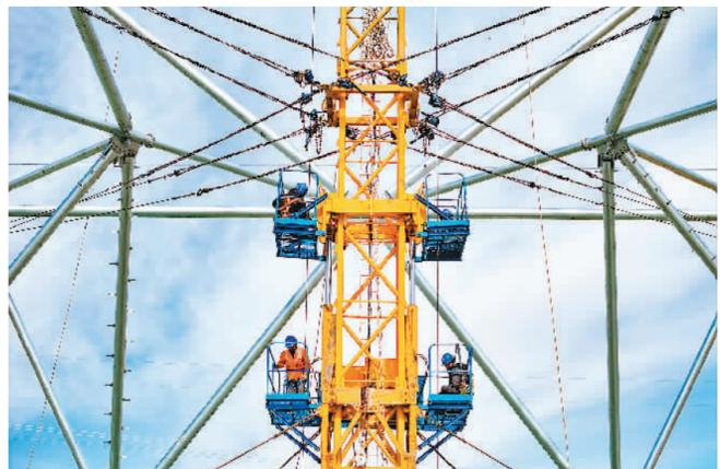
连日来，张北—胜利1000千伏特高压输电交流项目工程内蒙古段组塔工作进入高峰阶段，施工人员抢抓工期，力争早日完成组塔任务。该项目是国家“十四五”电力发展规划重点项目，计划年内投入运行。图为4月17日，工人在进行组塔作业。王正摄（新华社发）
