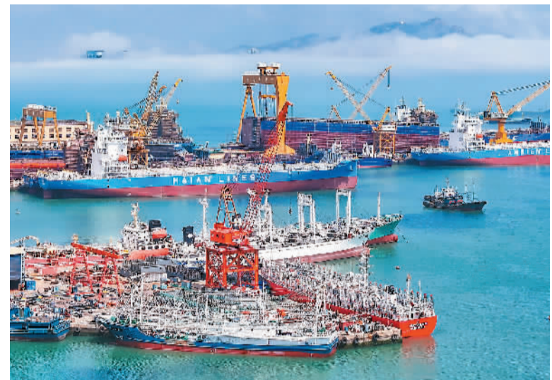
最近,在山东省荣成市石岛管理区修造船产业基地,工人们抓紧维修、建造各类大型船舶,基地内呈现一派繁忙、有序的生产景象。今年一季度荣成当地修造船企业出口船舶价值4.9亿元,同比增长33.6%。图为在荣成市石岛管理区修造船产业基地内,大型船舶正在建造、维修。
