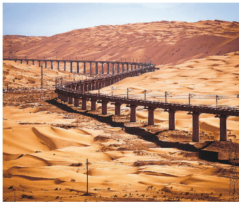
位于沙漠中的沙山沟特大桥。
