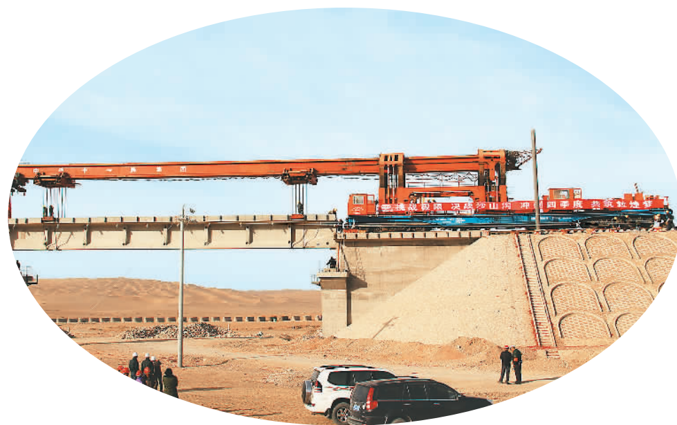
正在建设中的沙山沟特大桥。
