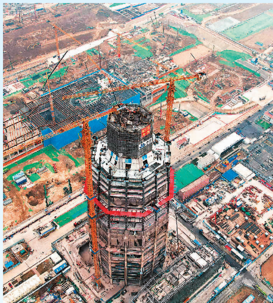
中国中化大厦建设现场。
