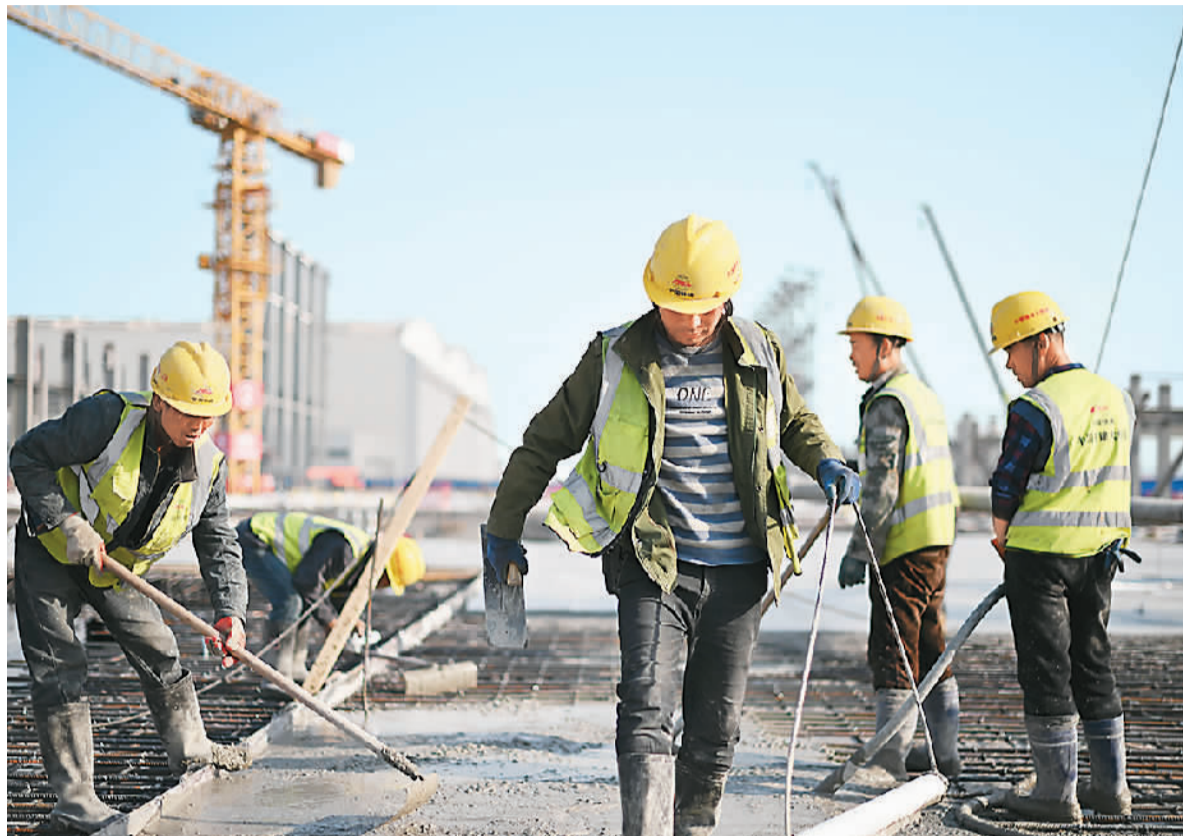
▲3月31日，空中客车天津A320系列飞机第二条总装线项目最大单体建筑——209总装厂房基础施工完成，正式转入主体施工阶段。该项目依托现有空客天津总装公司厂区进行建设，主要生产A320和A321系列飞机，预计2026年底交付投产。图为工人在该项目建设现场进行施工作业。 新华社记者 赵子硕摄
