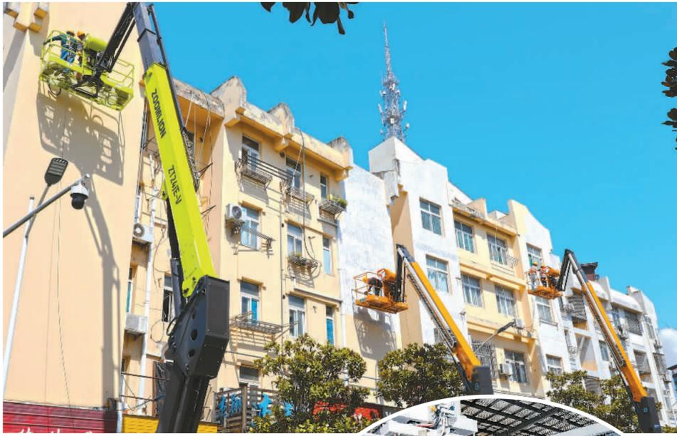
▲安徽芜湖市繁昌区有序推进老旧小区改造提升暖心工程，着力实施外墙立面修复、屋顶漏水修复、增设公共绿地等改造内容，积极推动绿色建筑、低碳建筑规模化发展。图为繁昌区繁阳镇安定西路一小区，施工工人正在云梯机上粉刷绿色环保外墙。
