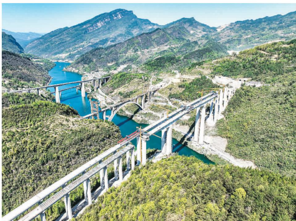
黄草乌江特大桥（右）位于重庆市武隆区境内，全长1702米，主跨220米，横跨乌江及G319国道，目前建设已进入最后的冲刺阶段，项目建成后将有效缓解渝湘复线高速公路通行压力。图为3月31日建设中的黄草乌江特大桥。
