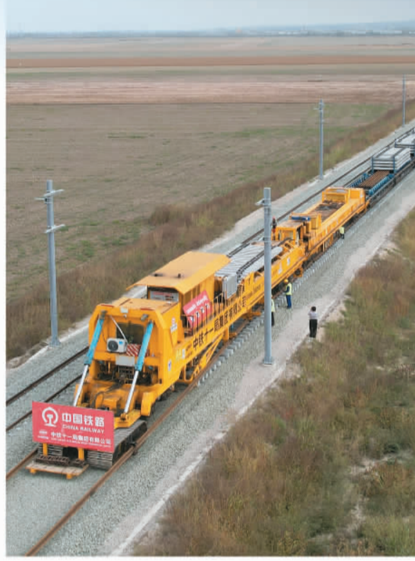
▼匈塞铁路塞尔维亚境内的诺苏段正紧张铺轨作业。刘瑜欣摄
