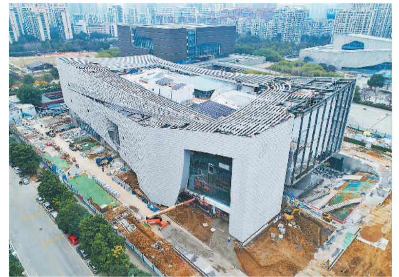
日前，合肥美术馆项目主体工程完工。该项目由中建八局华中公司承建，总建筑面积约3.6万平方米。项目以合肥市花桂花为创作原型，内部设置10个展厅，是集展览、陈列、培训、典藏、文化交流等功能为一体的综合性美术馆，建成后进一步提升城市功能和品位。图为俯瞰合肥美术馆。
