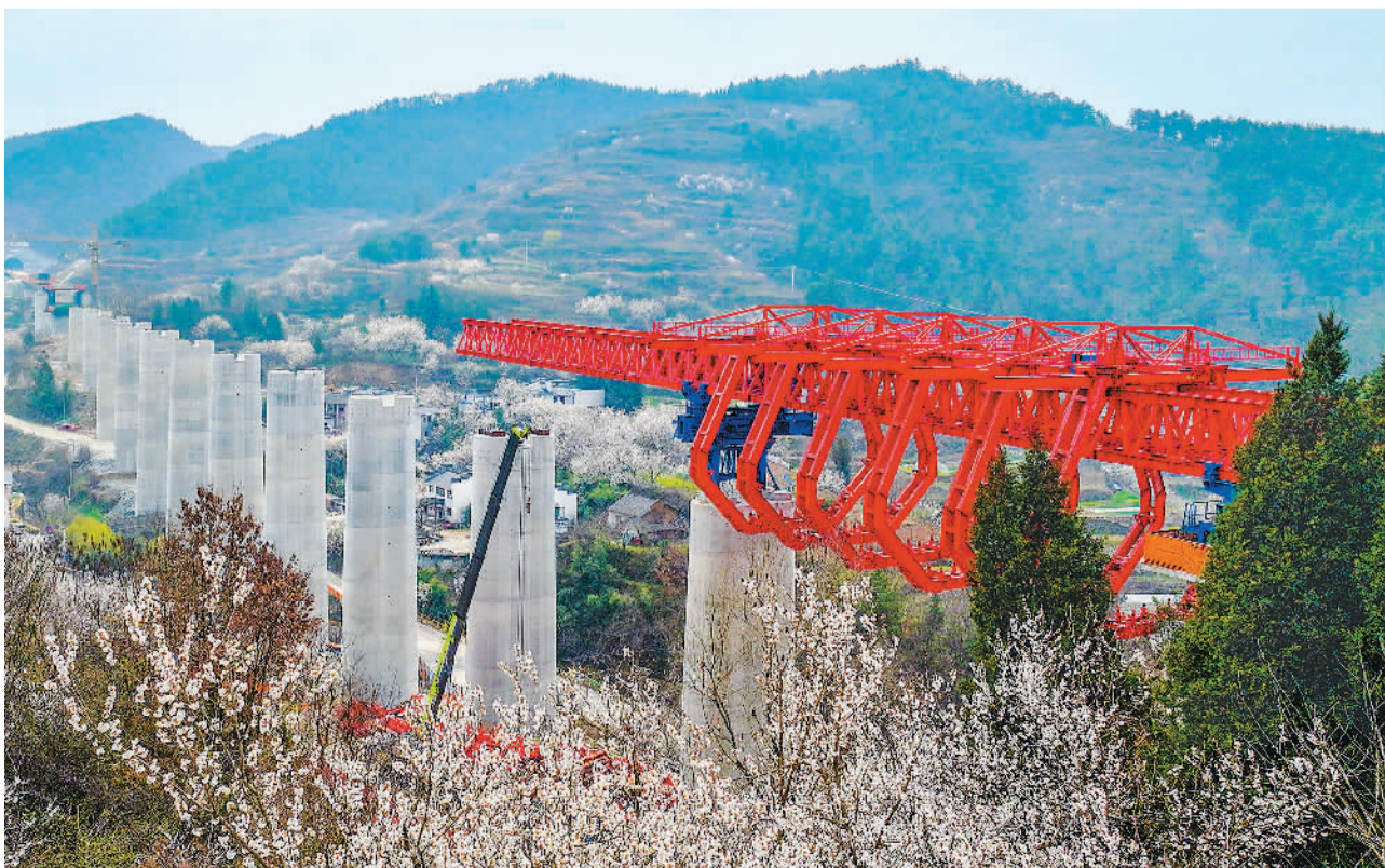
3月13日,工人们正在建设西(安)十(堰)高铁樱桃沟特大桥。该大桥位于湖北省十堰市,全长625.08米。西十高铁设计时速350公里,与武汉至十堰高铁相接,将成为武汉至西安快速铁路客运通道。 周家山摄(人民视觉)
