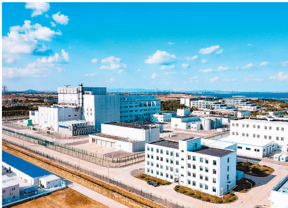
中国重大科技专项标志性成果、全球首座第四代核电站——华能石岛湾高温气冷堆核电站示范工程在山东荣成投入商业运行。 孙文湛摄
