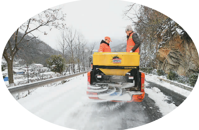
图为2月21日，工作人员在湖北省襄阳市保康县公路上抛洒融雪剂。陈泉霖摄（人民视觉）
