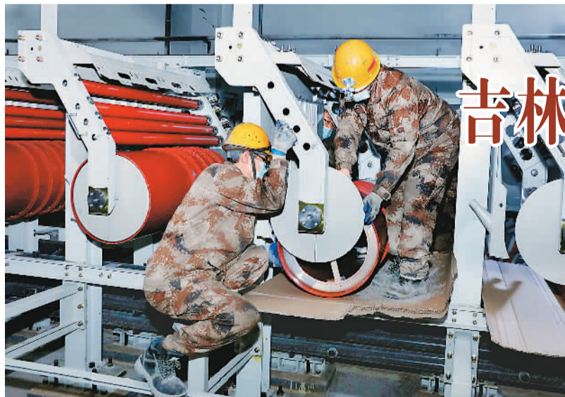
吉林化纤1万吨超细旦连续纺长丝项目现场。
