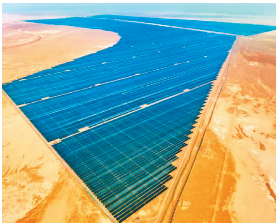
阿联酋阿布扎比艾达芙拉PV2光伏电站项目。
