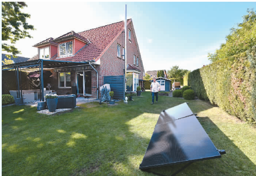
在德国施瓦茨贝格小镇，当地居民迪尔克家中安装了国产太阳能设备。 新华社记者 任鹏飞摄
