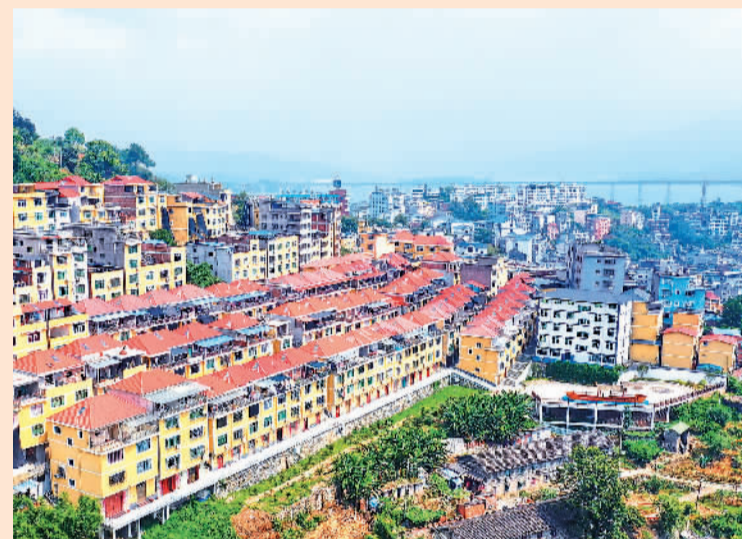
▲ 宁德市福安市下岐村被誉为“闽东连家船民上岸第一村”。1997年，宁德市福安市下岐村采取“分期分批，全面搬迁”的办法，将2000多名渔民安置上岸。图为下岐村新貌。 丁立凡摄
