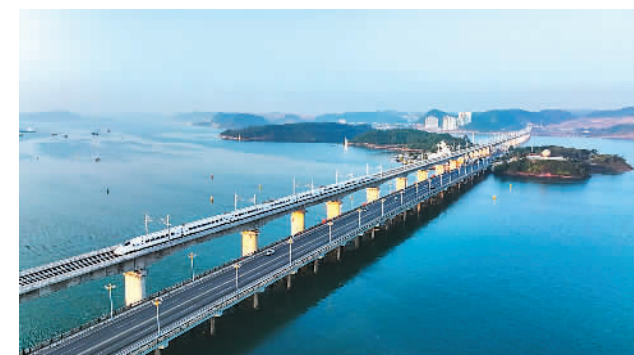
防东铁路2023年12月开通运营。列车从东兴市站首发，经过西湾海域前往防城港北站。旅客在车上可看到美丽的海景。图为防东铁路。刘华摄(人民视觉)
