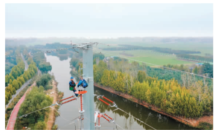
工人正在安装新型复合防鸟装置。
