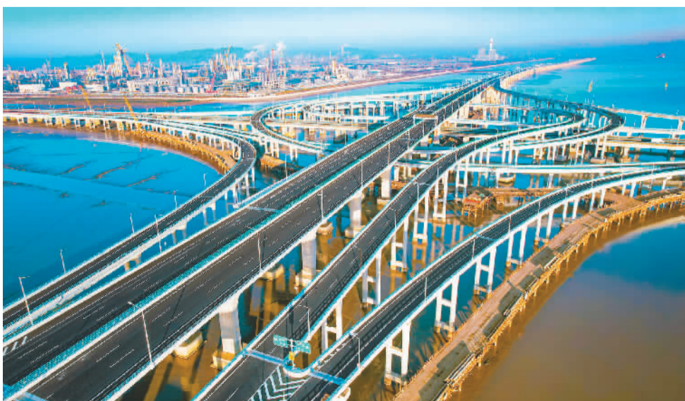
1月19日，杭州（杭州至宁波）高速复线宁波段一期工程正式通车，这也意味着亚洲最大海上交通枢纽——杭甬高速复线宁波段一期项目滨海互通枢纽同步开通。该项目建成通车后，将与杭州湾跨海大桥、甬舟高速金塘大桥相接，缩短长三角南翼与上海、江苏等地的距离，极大便利杭州湾沿线居民出行。
