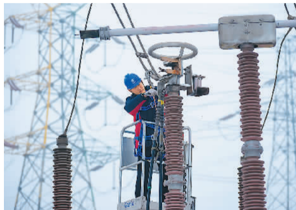
近日，山西省运城市积极开展雨雪冰冻灾害天气防范应对工作，对易覆冰输电线路开展全天候检测并开展融冰作业，保障电网安全稳定运行。图为国家电网运城供电公司工作人员在开展融冰作业准备工作。
