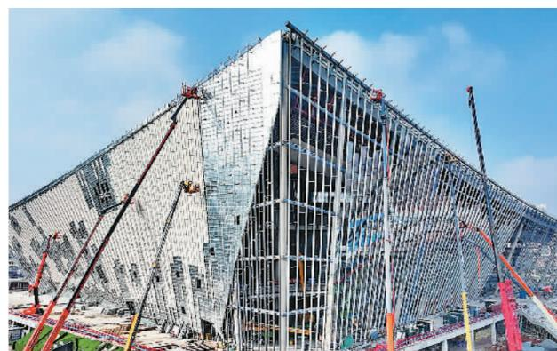
南昌保利大剧院是江西省在建规模最大的剧场，项目施工方利用建筑信息模型（BIM）技术，对幕墙模型进行大数据分析，优化拼装步骤。图为1月4日项目建设现场，多台作业车伸出“长臂”，辅助工人安装幕墙陶铝板。 朱海鹏摄（人民视觉）
