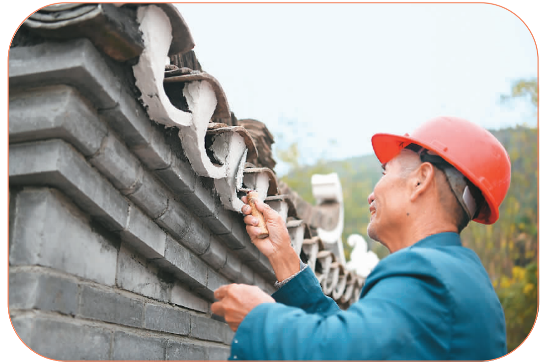
广西建筑工匠学院乡村传统建筑工匠培育基地的学员在思源民俗博物馆砌筑马头墙。秦钟明摄
