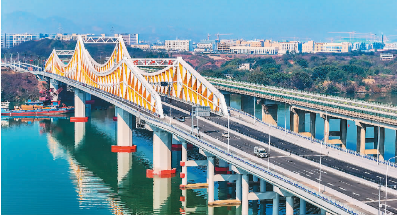
12月28日，位于江西省赣州市的螺溪洲大桥建成通车。螺溪洲大桥全长1.74千米，主桥钢桁梁总重约1.5万吨，采用步履式千斤顶将梁段分为五个轮次分阶段顶推架设。该桥是一座跨越赣江的大型钢桁架桥，也是国内首个采用全K型桁架结构的大跨径桥梁。
