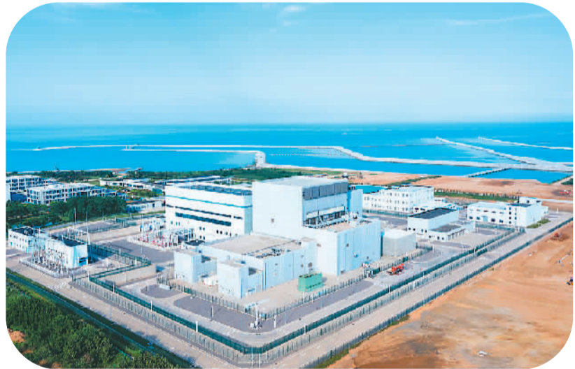
12月6日，国家重大科技专项标志性成果、全球首座第四代核电站——华能石岛湾高温气冷堆核电站示范工程在山东荣成投入商业运行。
