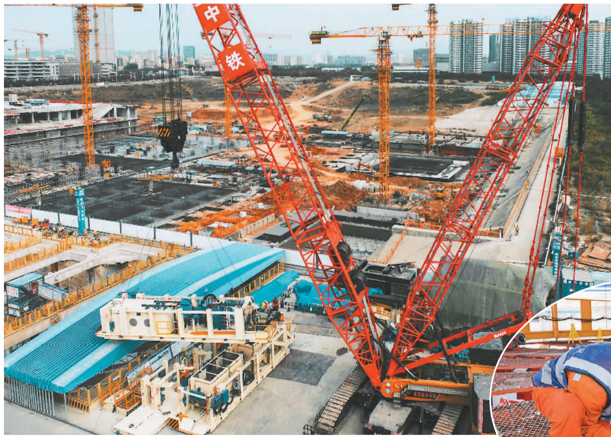
上图：位于广东东莞的深江铁路深莞隧道西段施工现场。
