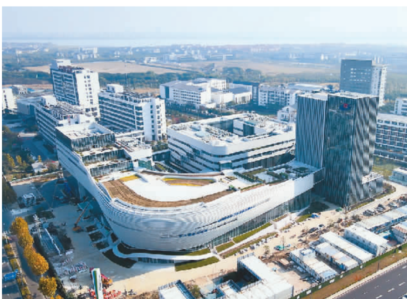
近日,由中建八局承建的苏州疾病预防控制中心迁建项目竣工交付。该项目位于江苏省苏州市相城区太平街道,总建筑面积约7.8万平方米,由实验室、生物样本库、健康展示馆等组成,建成后为开展疾病早期干预和识别手段研究、促进科研成果转化提供了重要场所。 冉一帆摄(人民视觉)
