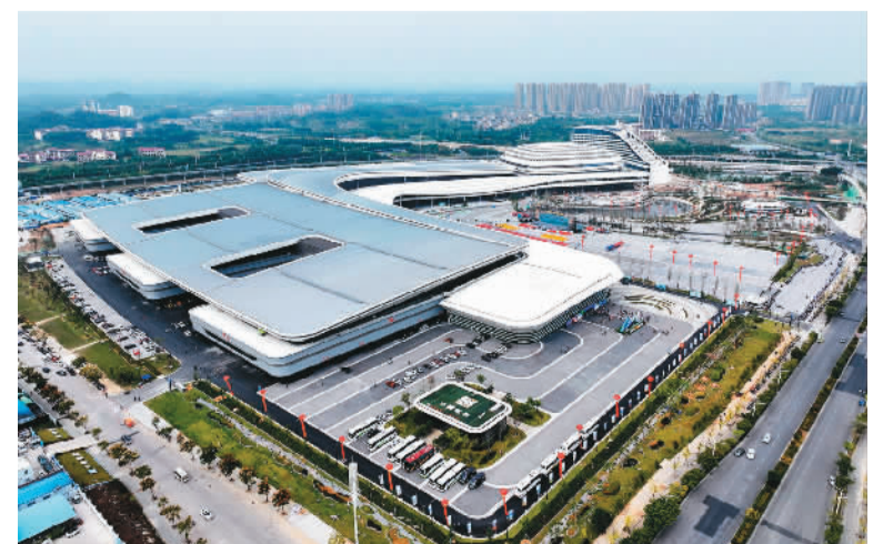
由中建八局南方公司承建的桂林国际会展中心近日正式启用。项目位于广西壮族自治区桂林市临桂区，总建筑面积31万平方米，是集会议、会展、商业、接待为一体的大型会展建筑综合体。项目可满足举办国际赛事、召开国内高端会议的需求，将对桂林对接东盟国家合作、打造世界级旅游城市品牌发挥重要作用。
