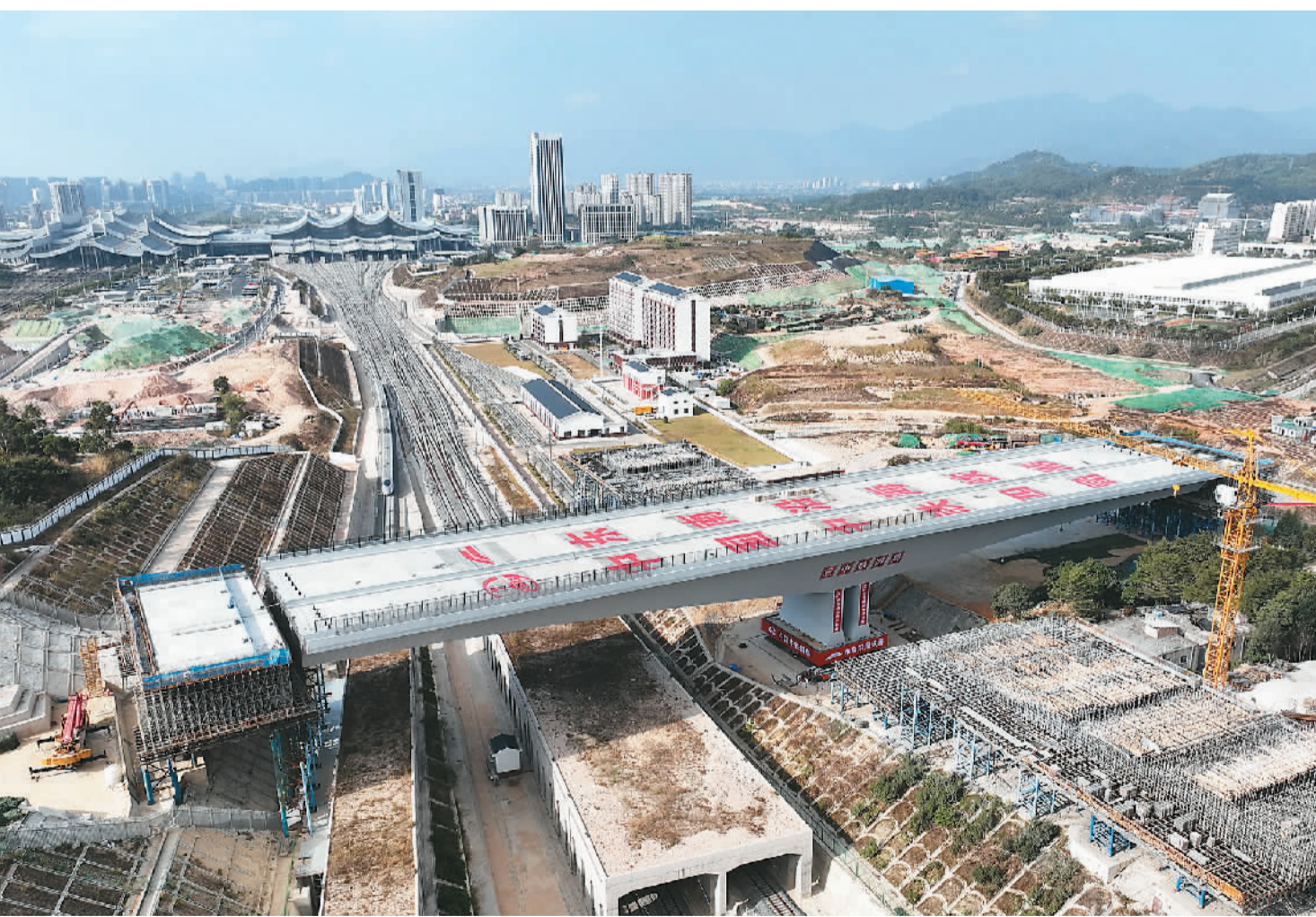
近日，福建厦门跨东海域通道北延伸段工程上跨福厦高铁公路桥转体梁成功转体，标志着项目建设取得突破性进展。该工程采用“先建桥后转体”的施工方式，确保福厦高铁安全运行。据介绍，该转体梁也是世界同类型工程中跨度较大、重量较重的混凝土T构转体梁。图为施工现场。 新华社记者 林善传摄
