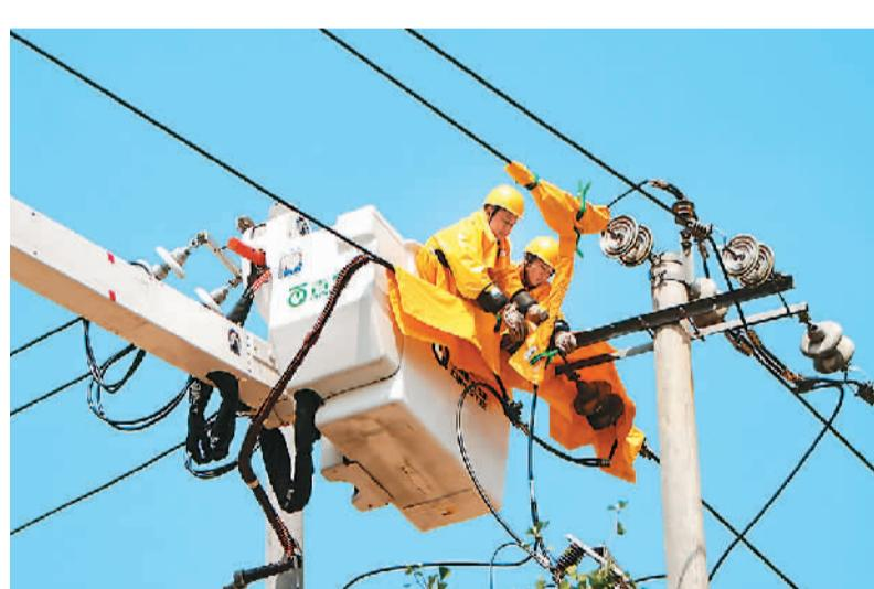
近日，南方电网贵州遵义凤冈供电局配网带电作业班顺利完成10千伏凤城Ⅱ回和Ⅳ回线路升级改造工作，本次“带电作业”实现客户“零感知”，有效保障了居民迎峰度冬期间安全稳定用电。肖晓梦摄
