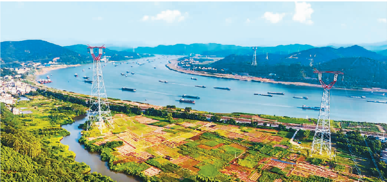
日前，由南方电网广东电网公司规划建设广东目标网架主体工程顺利投产。该工程包括建设一批交、直流工程项目，将大电网划分为多个既能分区运行、又能相互支撑的小区域网架，全部投产后粤港澳大湾区的供电能力将大幅提升。图为广东目标网架主体工程之一的粤港澳大湾区500千伏外环西段跨越肇庆西江河段线路。沈甸摄（人民视觉）
