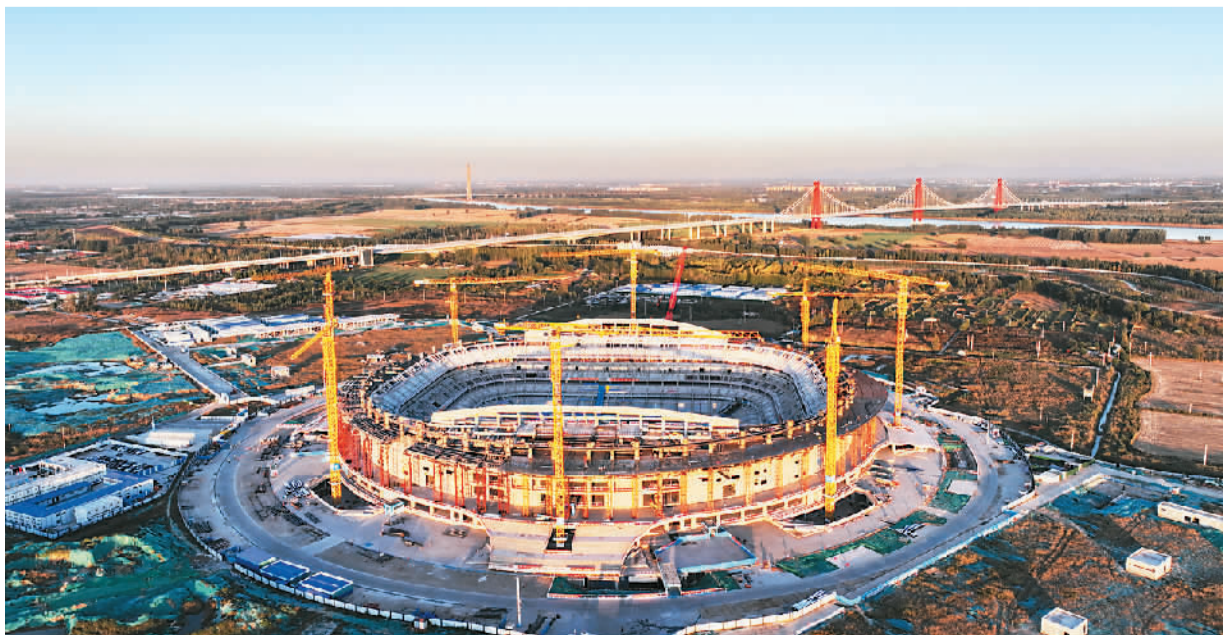
日前，山东省济南市黄河体育中心专业足球场项目完成主体结构和下部钢结构施工，全面进入屋盖钢结构施工阶段。该项目由中建八局承建，总建筑面积为19.73万平方米，总用钢量约3.5万吨，采用国际足联最新标准建造，是山东省首个6万座足球场，预计2024年底竣工。
