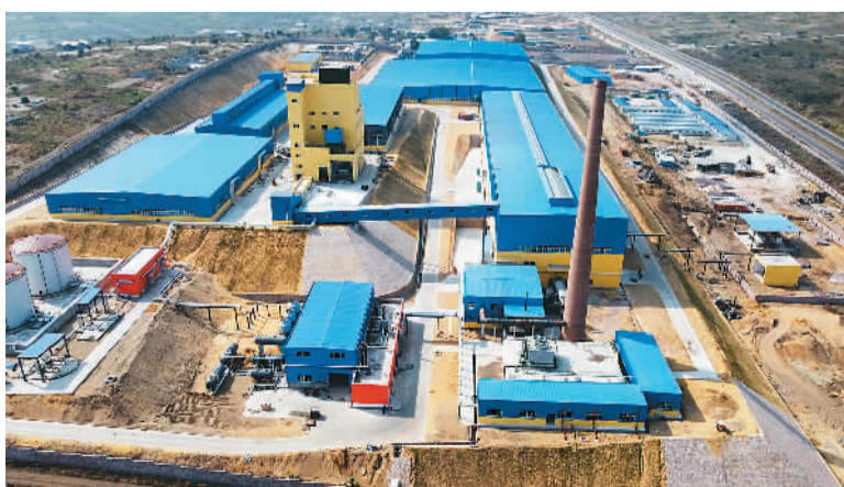
图为建成的刚果(布)红星玻璃厂工程。 中铁八局海外公司供图
