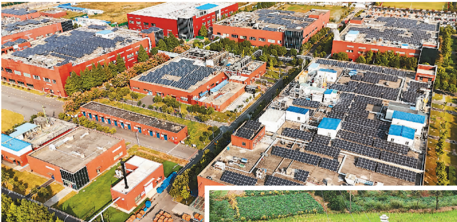
▲近年来，江苏省连云港市充分利用工业厂房、建筑屋顶等闲置资源，全面推动光伏项目发展，让“绿色”覆盖城市“屋顶”。图为在连云港高新区海州工业园，正大天晴药业集团股份有限公司屋顶光伏电站进行扫尾施工。
