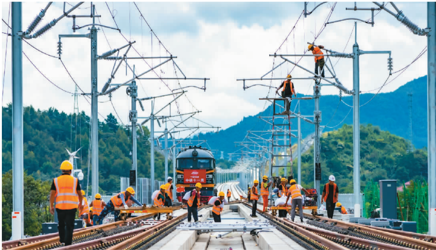
池黄高铁位于安徽省皖南山区，是武汉至杭州高速铁路通道的重要组成部分，线路起自池州站，至黟县东站与在建昌景黄高铁共站并线至黄山北站，新建正线长约125公里，设计时速350公里。目前，池黄高铁接触网、电力变电、通信、信号等四大专业的电气化施工已全面展开。图为近日，池州市青阳县蓉城镇牌楼村，工人在新建池州至黄山高速铁路九华山站段安装电力设备。陈光学摄（人民视觉）
