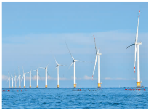
由一座座陆地、海上风场，光伏和生物质电站提供的绿色电能，正在东北能源供给中扮演重要角色，对保障电力安全可靠供应、加快能源绿色低碳转型具有重要意义。图为辽宁大连庄河海上风电项目。新华社记者 杨青摄
