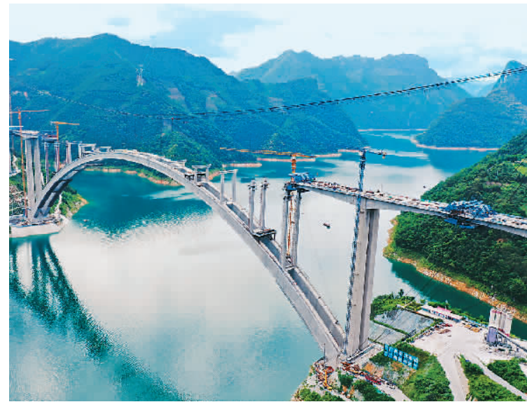
建设中的天峨龙滩混凝土拱桥（摄于2023年9月1日）。 广西大学供图
