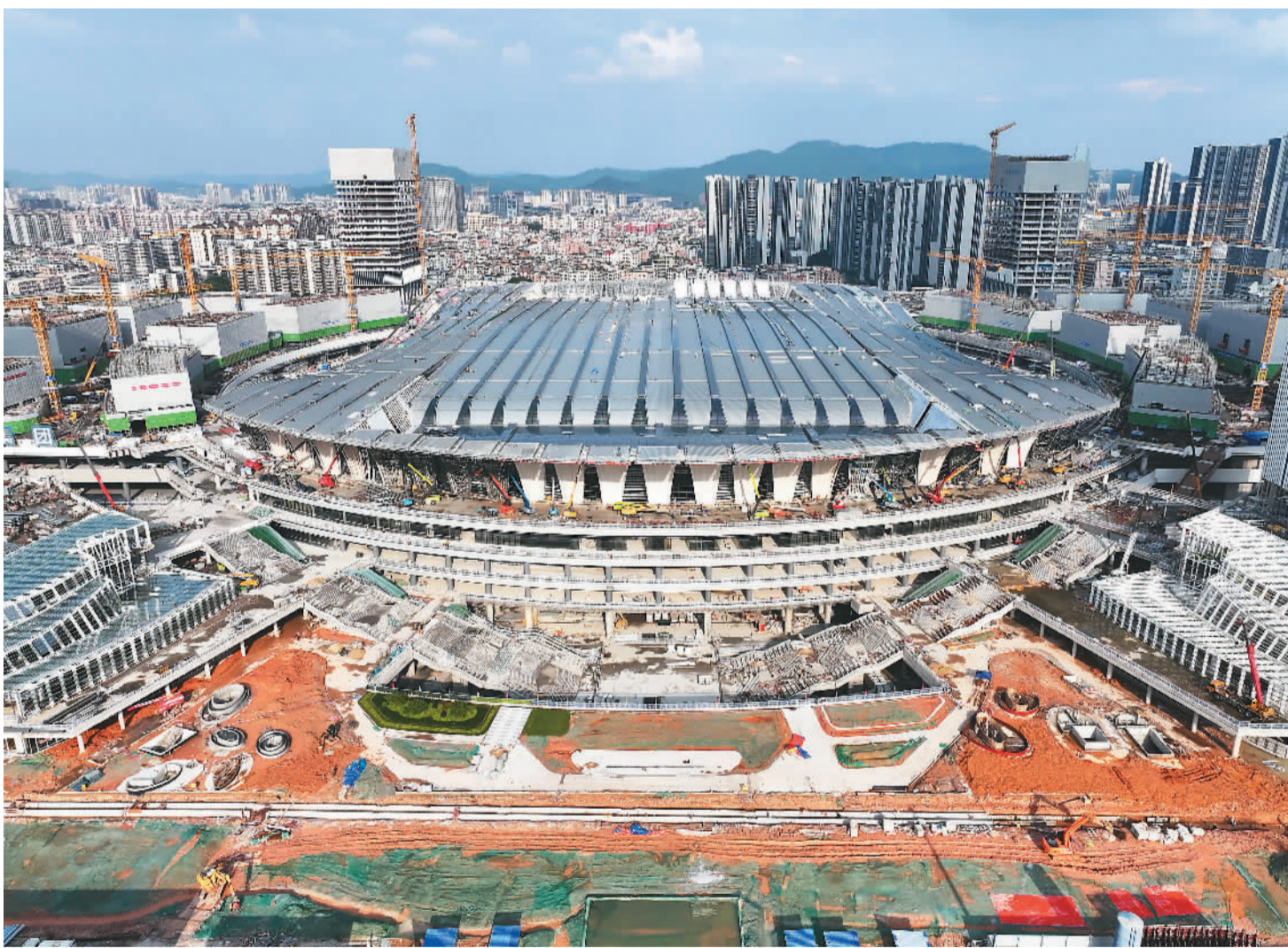
目前，广州白云火车站项目建设正在有序推进中。广州白云站是粤港澳大湾区首个在建的按现代综合交通枢纽规划建设理念打造的特大型枢纽工程，该站建成运行后，将有力推进粤港澳大湾区内高铁、普铁、城际等融合衔接，构建完善、轨道上的大湾区。
