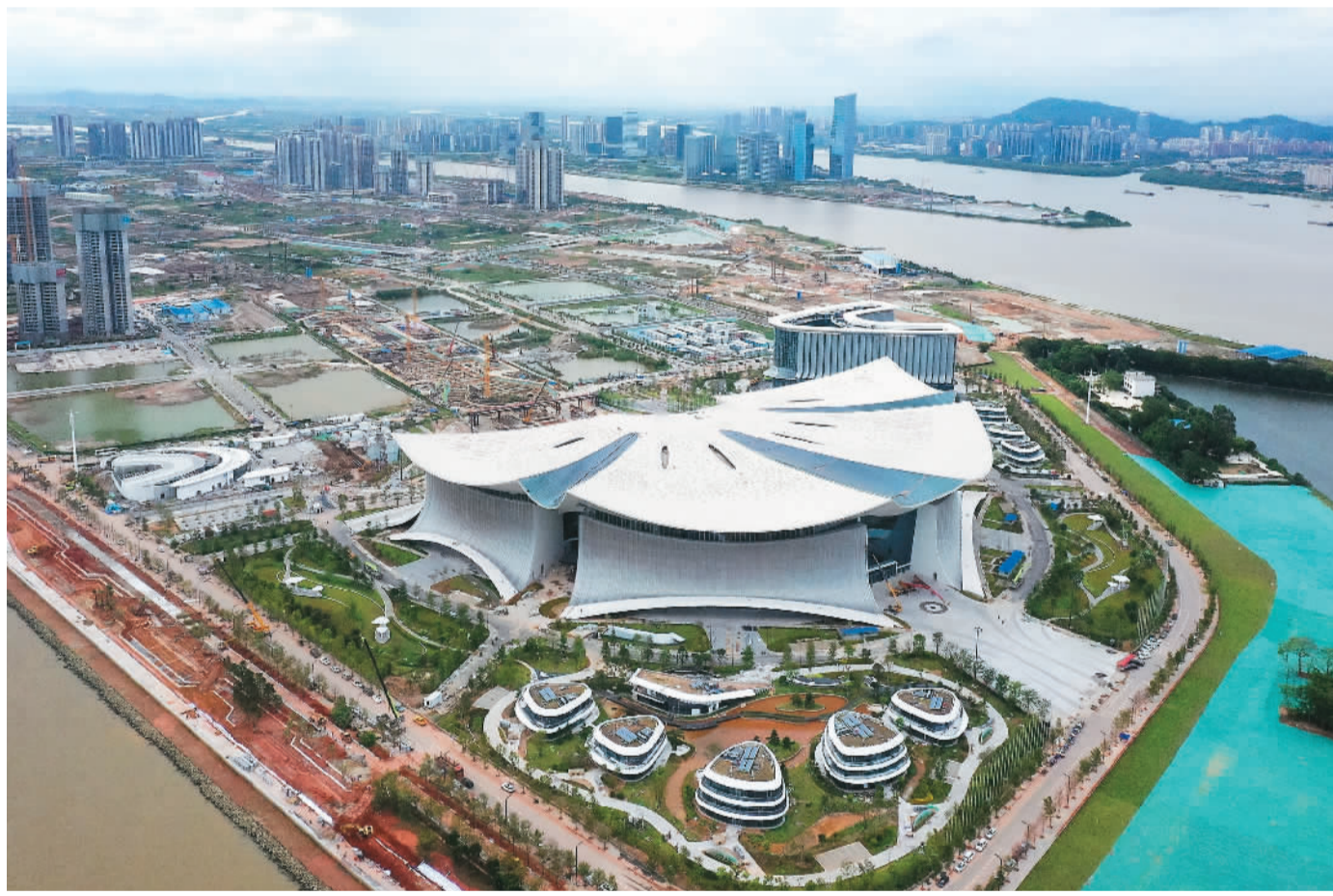
9月14日，中国能建开建设的南沙国际金融论坛永久会址项目竣工，即将投入使用。该项目位于广州市南沙新区横沥岛尖，以“木棉花开，鸿翔海丝”为设计理念，空中俯瞰，永久会址宛如迎风绽放的木棉花。国际金融论坛是全球金融领域高级别常设对话交流和研究机构。新华社记者 刘大伟摄
